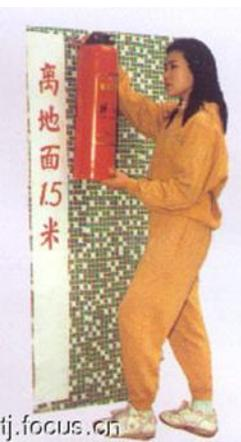
1. 右手拖着压把，左手拖着灭火器底部，轻轻取下灭火器
